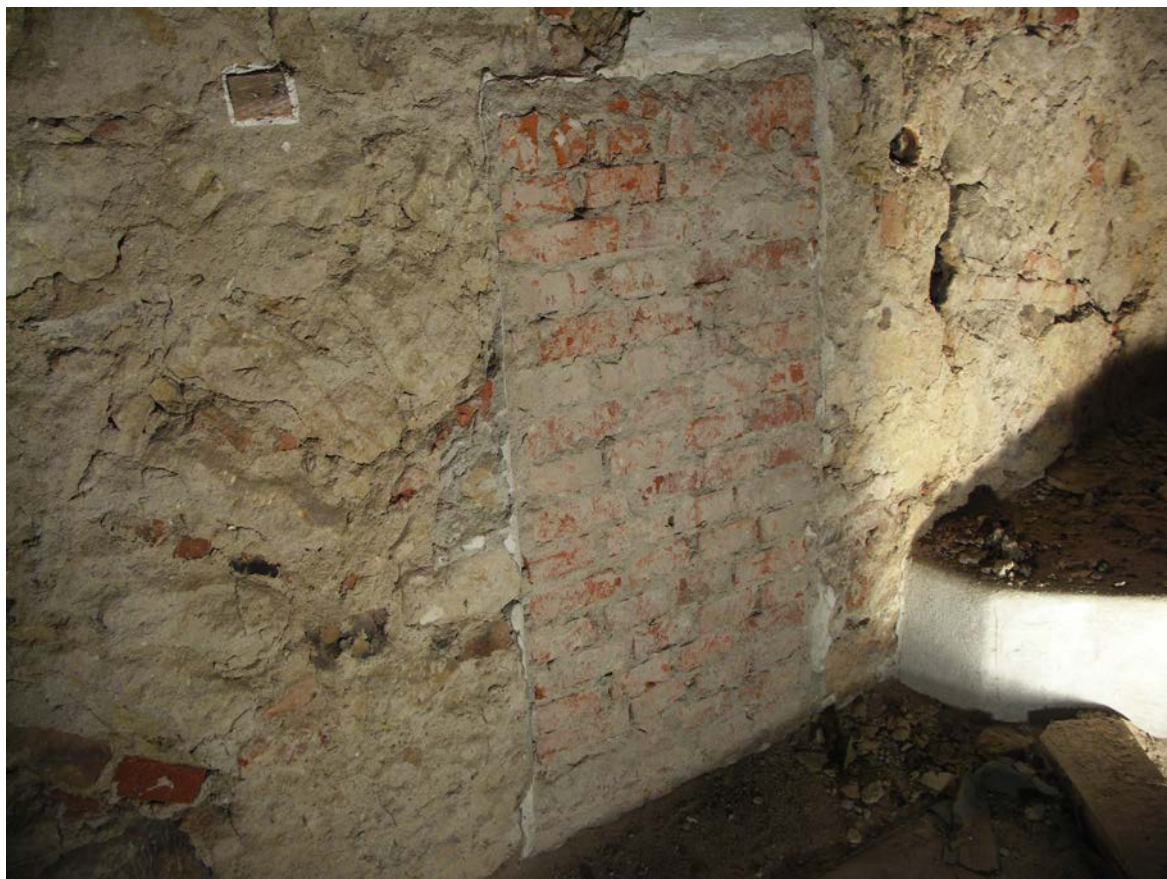
Česká Lípa, ulice Tržní, dům čp. 159. Interiér, 1. NP, místnost č. 14, východní stěna, střední část, detail zazděného klenebního pasu, pohled od severozápadu.
