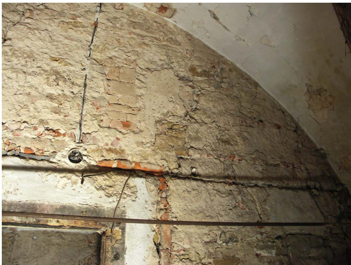
Česká Lípa, ulice Tržní, dům čp. 159. Interiér, 1. NP, místnost č. 12, východní stěna, jižní část, detail stop po původní horizontální konstrukci, pohled od severozápadu.
