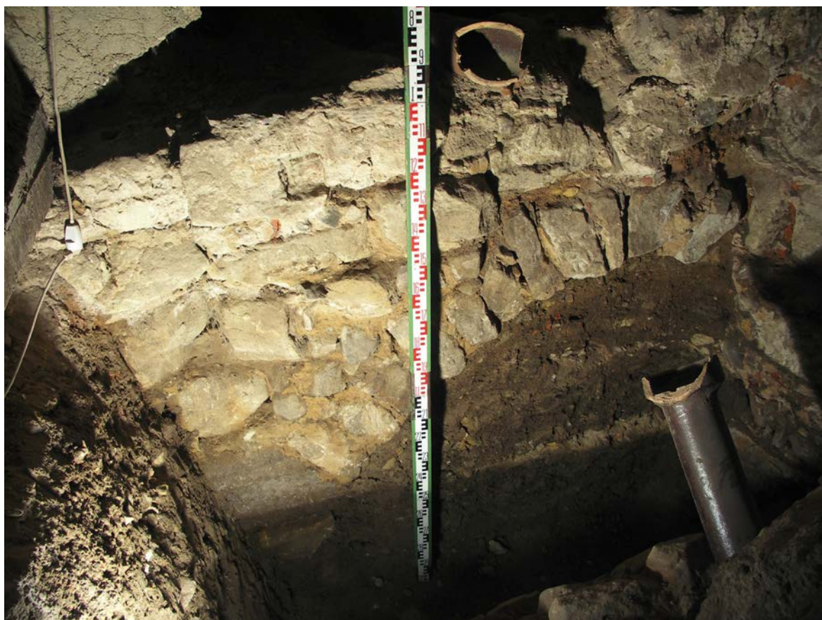
Česká Lípa, ulice Tržní, dům čp. 159. Interiér, 1. NP, místnost č. 17, základový pas bývalé jižní stěny odhalený archeologickým výzkumem, pohled od severu.
