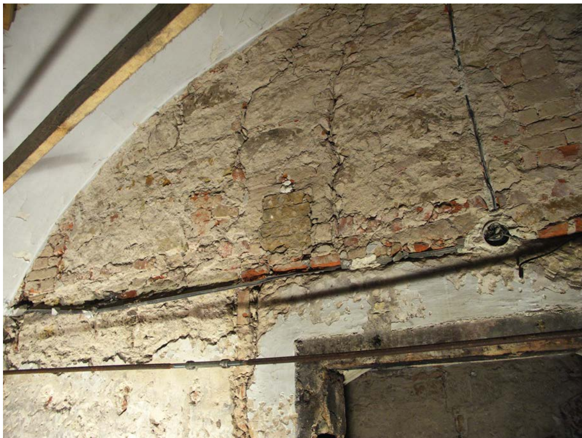
Česká Lípa, ulice Tržní, dům čp. 159. Interiér, 1. NP, místnost č. 12, východní stěna, severní část, detail stop po původní horizontální konstrukci, pohled od jihozápadu.
